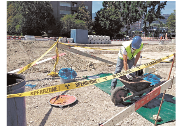
Abb. 21: Triage der radiumkontaminierten Abfälle bei den Aushubarbeiten in der ehemaligen Deponie Lischenweg
