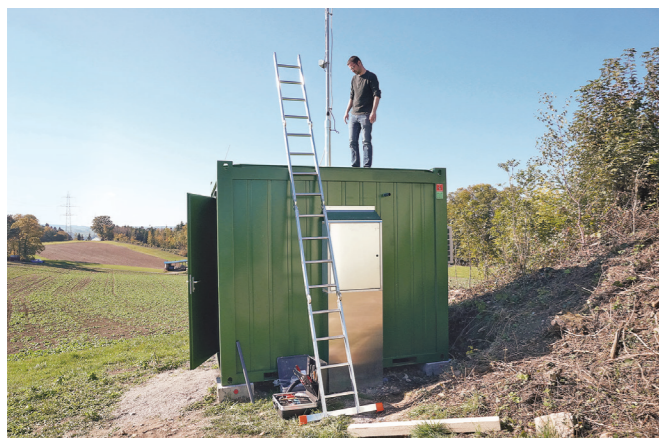
Abb. 1: Daniel Lienhard bei der Installation einer Sonde in einer Messbaracke
